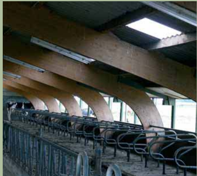
Ejemplo de estructura de madera laminada en una explotación ganadera.
